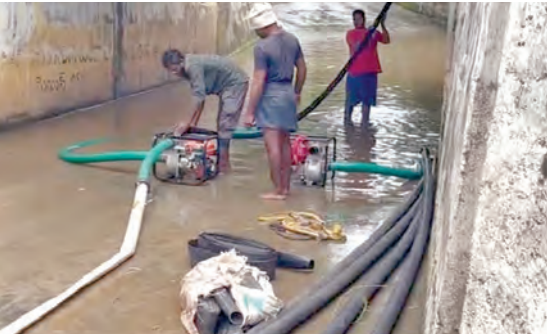
డిజిల్ ఇంజనీతో అండర్బ్రెడ్జి వద్ద నీరు తొలగిస్తున్న సర్పంచ్ నిర్ణయ పెందరెడ్డి.
